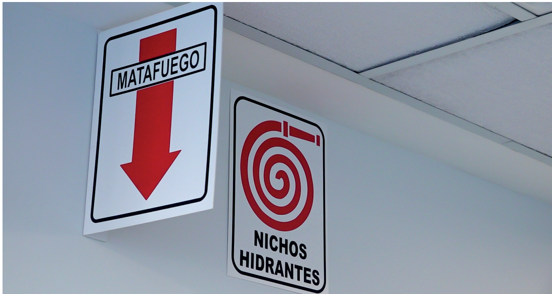
Cartelería de Incendio. Fuente: SRT
